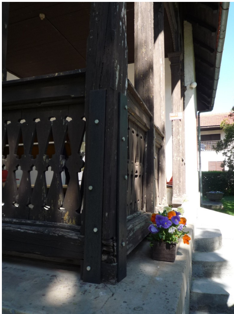
Oszloperősítés ideiglenes megoldással
